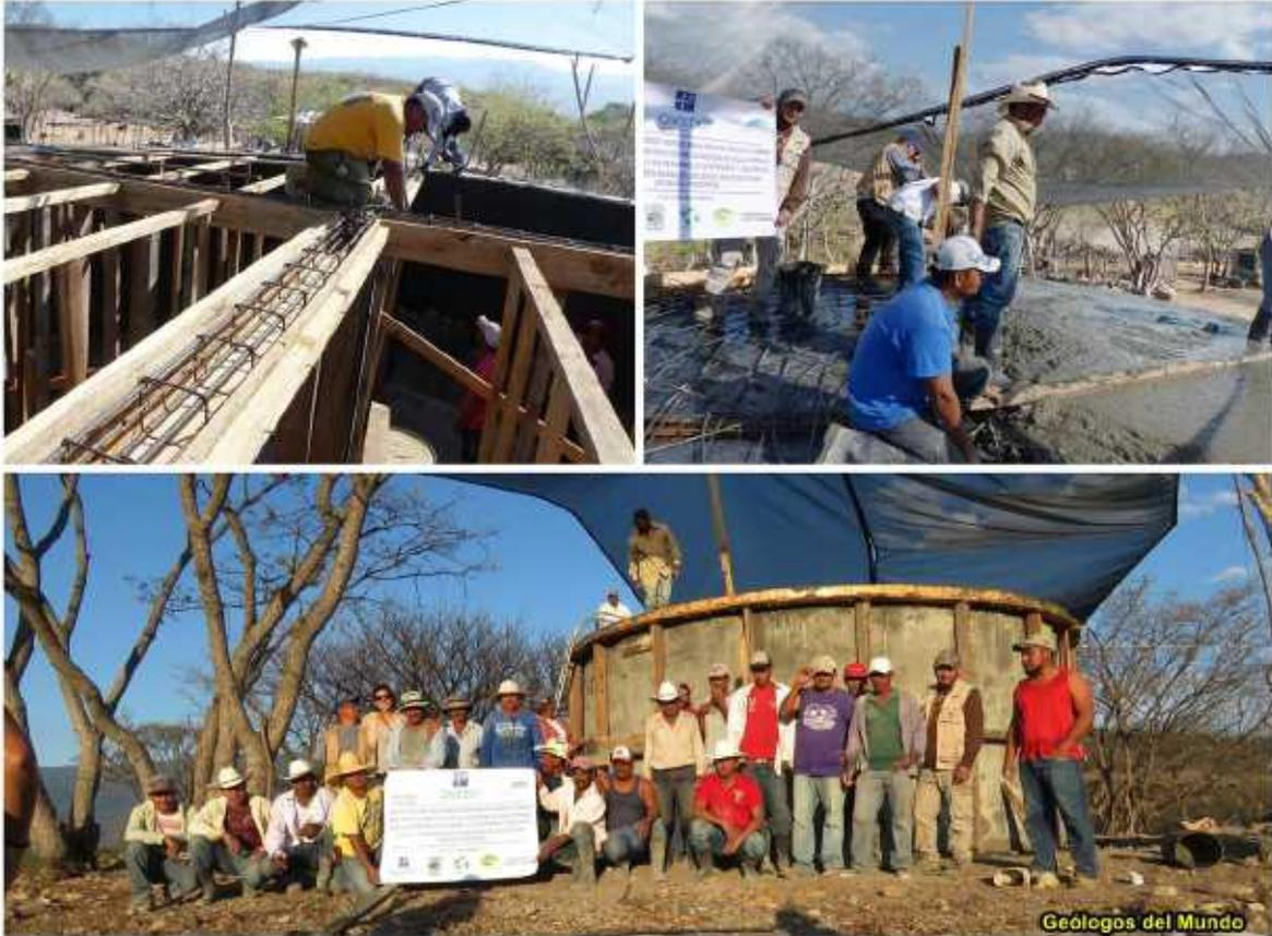
*Cubrición del depósito. Construcción de las vigas y de la losa superior con hormigón armado. En esta fase, al realizarse todo el trabajo a mano y ser necesario llevarlo a cabo en el menor tiempo posible, requiere una gran participación comunitaria.*
