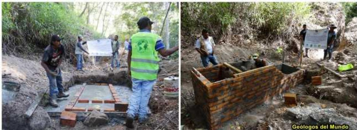
*Construcción del desarenador. Cimentación y levantamiento de paredes y divisiones interiores.*
