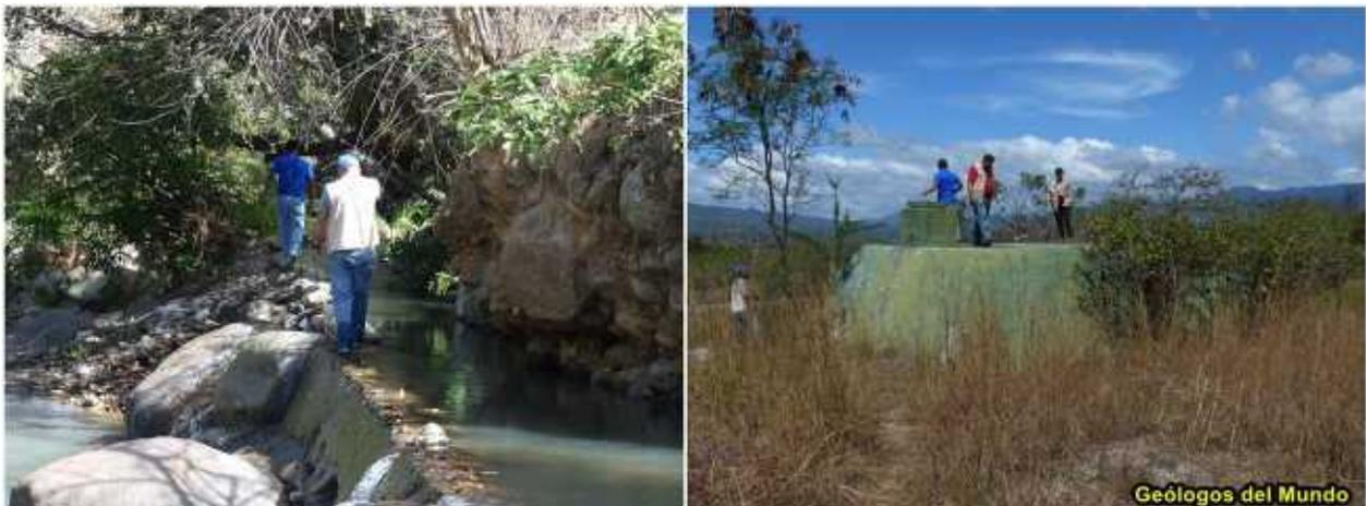
*Captación mediante azud de derivación y depósito de almacenamiento del antiguo sistema de agua de la comunidad de Angostura.*
