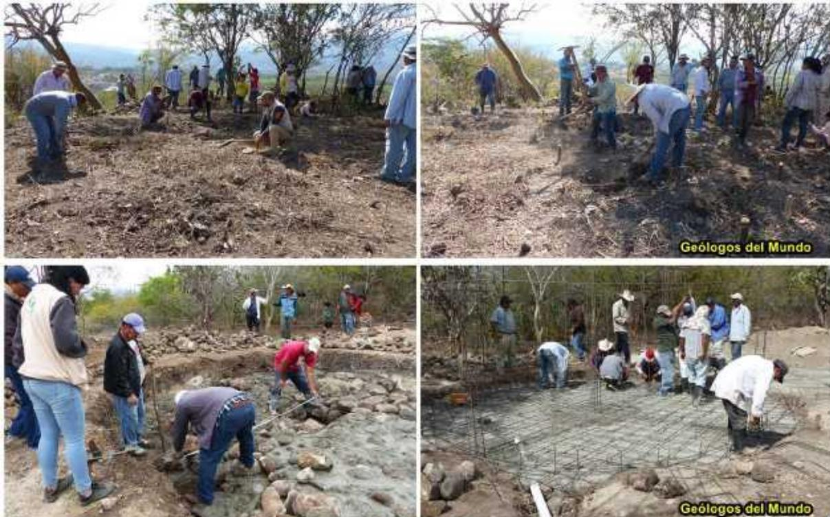
*Etapas de replanteo, excavación y cimentación.*
