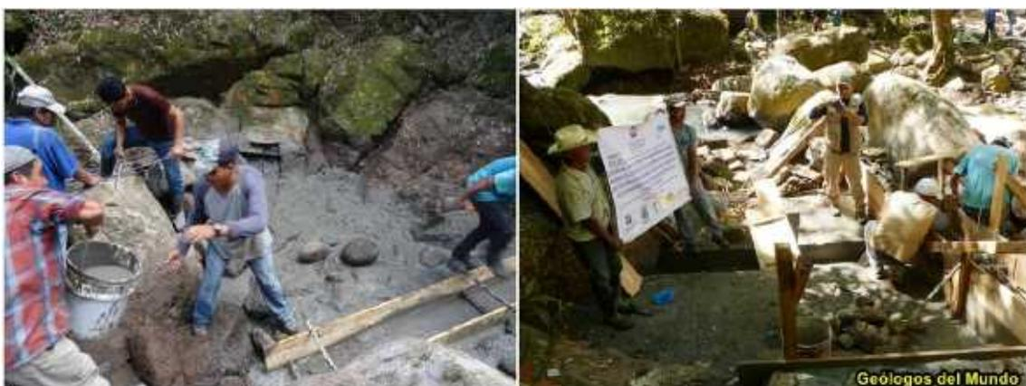
*Construcción de cimentación del vaso y muro de cerrada.*
