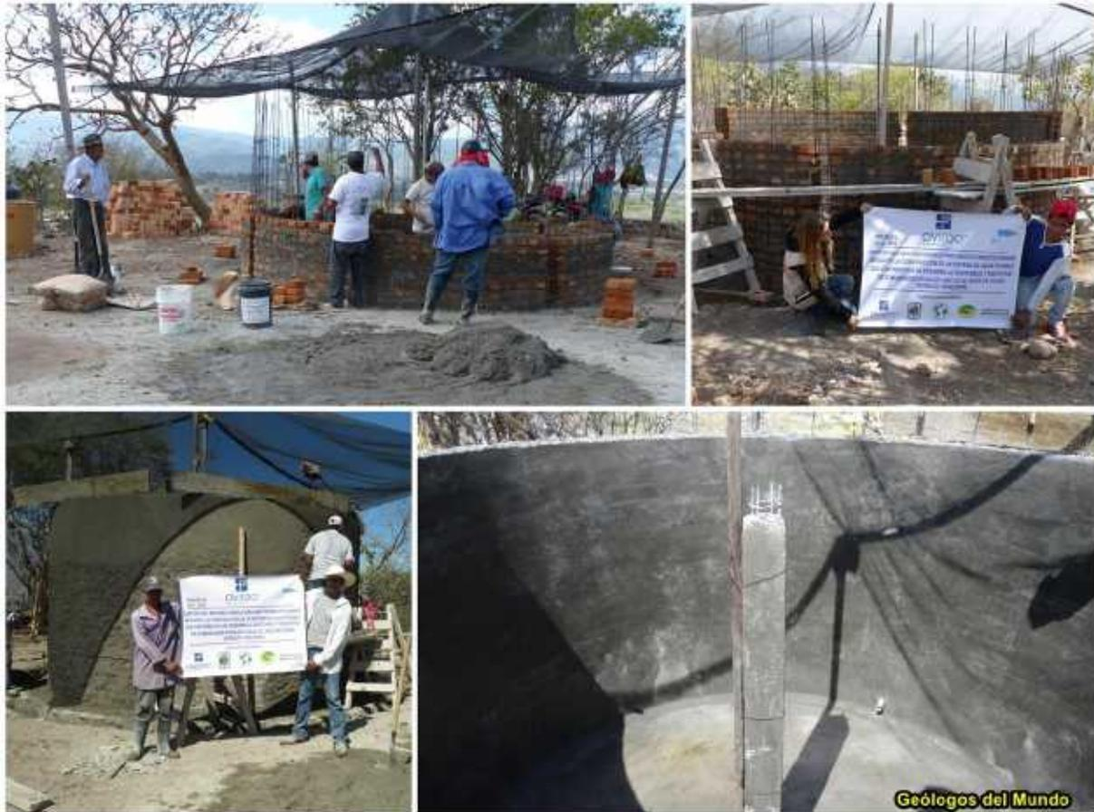
Levantando las paredes de ladrillo rafón reforzado por un entramado de varilla de acero corrugado y por los pilares perimetrales. Repello exterior e interior y pulido interior. En la fotografía inferior derecha se puede ver la columna central.
