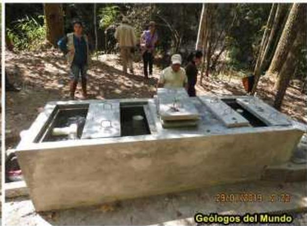
*Construcción del cierre superior con tapaderas practicable para inspección y mantenimiento; en la imagen derecha, el desarenador ya en funcionamiento*
