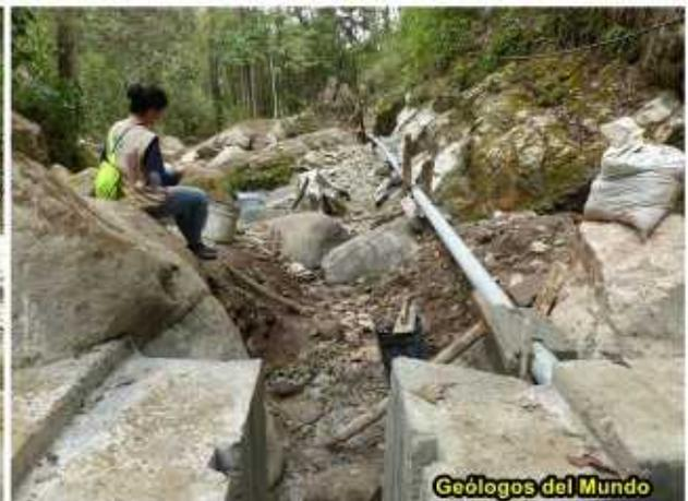
*Línea de conducción obratoma-desarenador ya instalada. A la izquierda se puede ver el paso aéreo realizado.*
