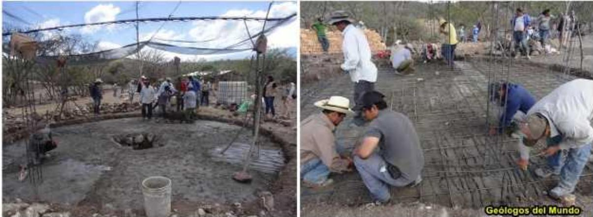
*Cimentación y armado de la solera*
