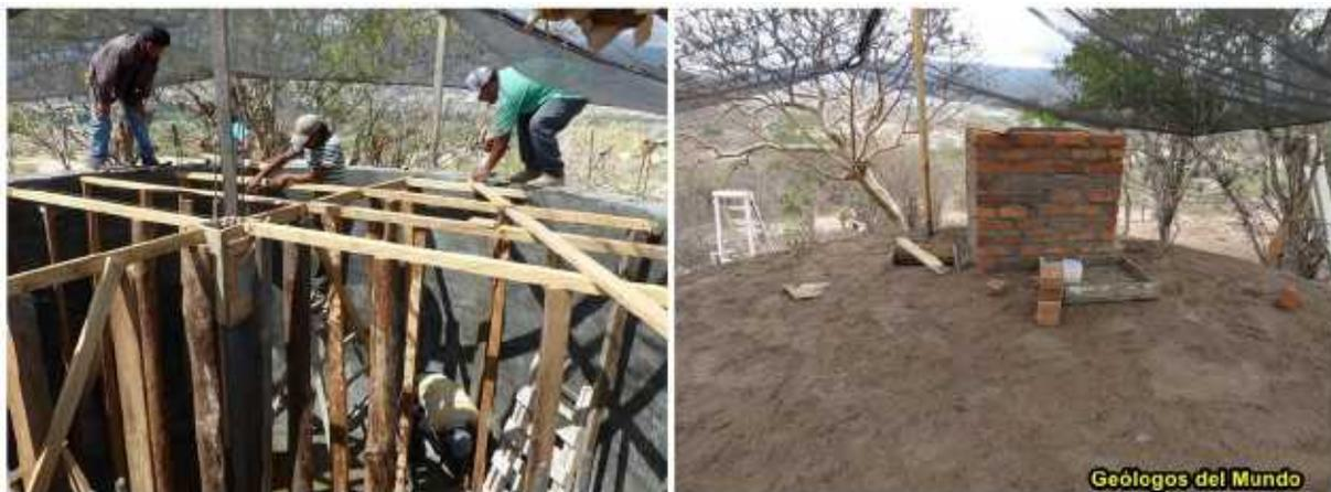
Encofrando para el fundido de la losa de cubrición. A la derecha, construyendo el hipoclorador sobre la losa ya fundida.
